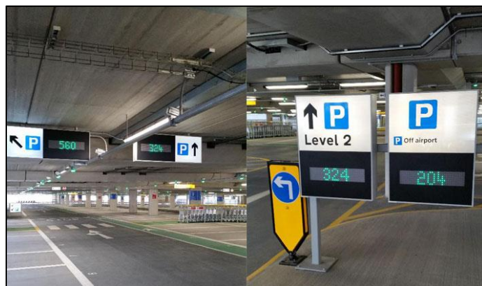
شکل ۴-۳- سیستم اطلاع رسانی پارکینگ طبقاتی
