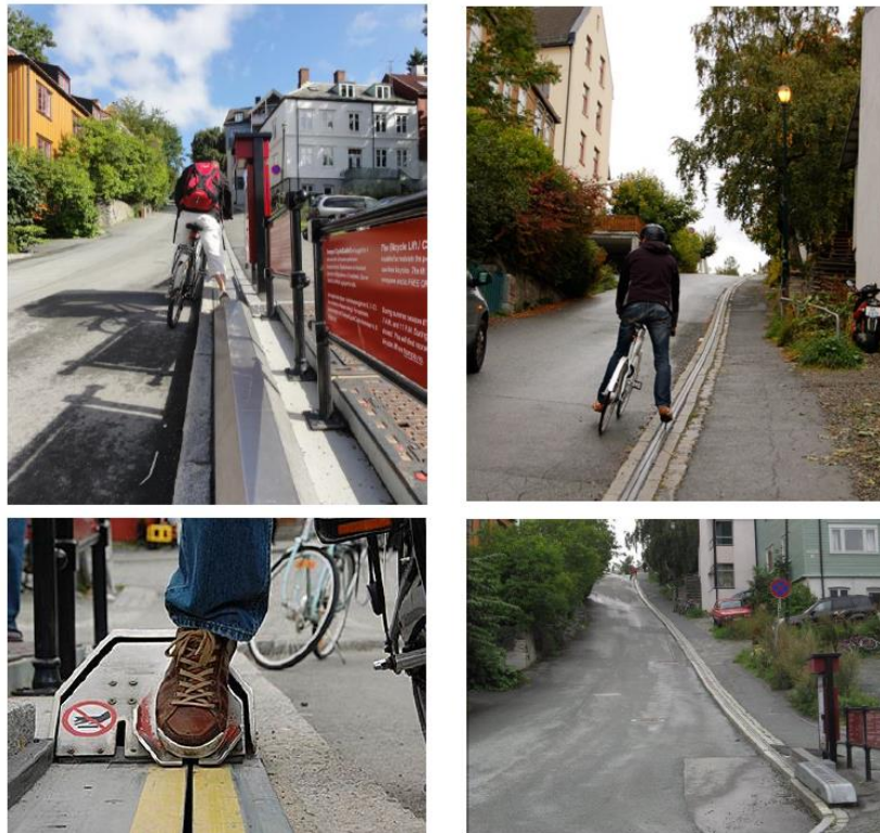
شکل ۳-۱۰- راه کارهایی به منظور غلبه بر شیب معابر برای دوچرخه سواری
